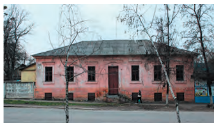
7.2. Вул. Гвардійська, 8. Загальний вигляд будинку. Фото 2013.
