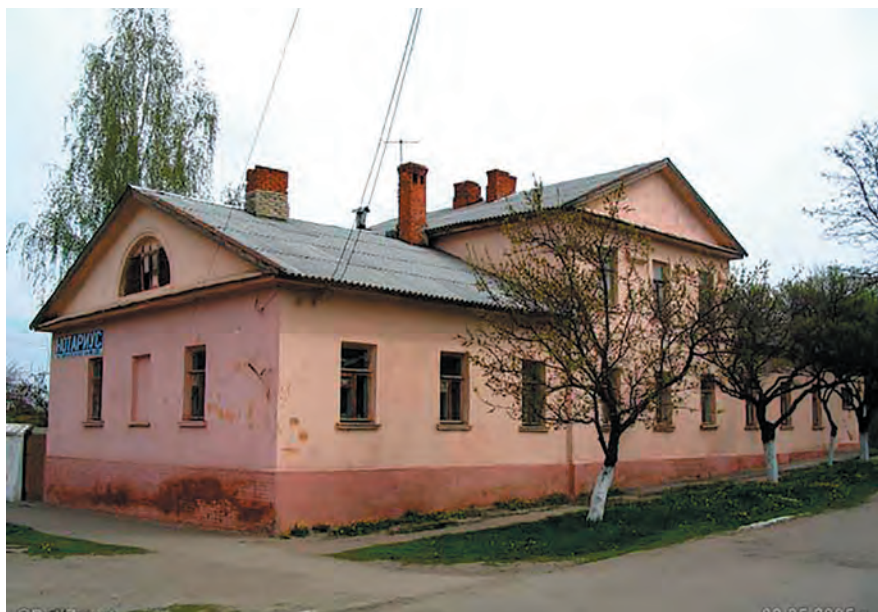
7.6. Фасад з боку вул. Старонікольської. Фото 2007.
