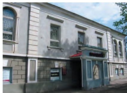
7.4. Центральна частина головного фасаду. Фото 2007.
