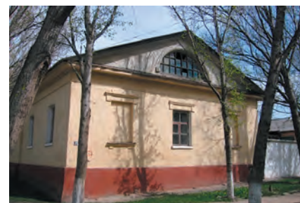
7.5. Торцевий фасад казарми. Фото 2007.
