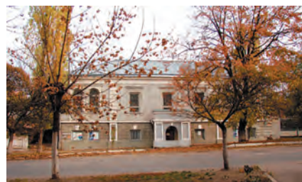
7.4. Загальний вигляд. Фото 2007.
