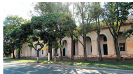
1.4. Фрагмент північного фасаду. Фото 2017.
