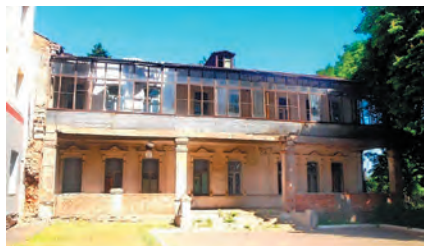
7.7. Західний фасад з галереєю. Вигляд з боку двору лікарні. Фото 2015.
