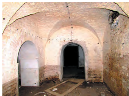
1.4. Фрагмент підвального приміщення. Фото 2017.
