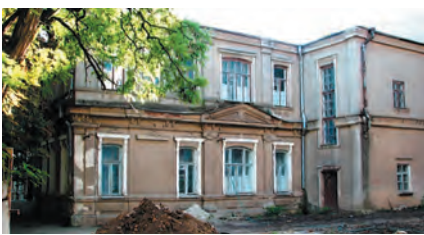
7.7. Північний фасад. Вигляд з боку двору лікарні. Фото 2007.
