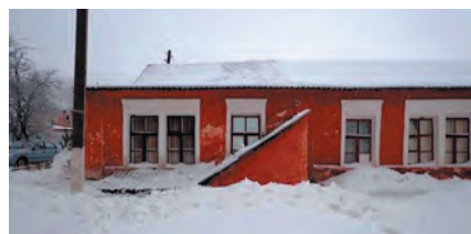
8.1. Фрагмент головного фасаду. Ліве крило будівлі. Фото 2017.
