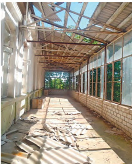
7.7. Галерея 2-го поверху. Фото 2015.
