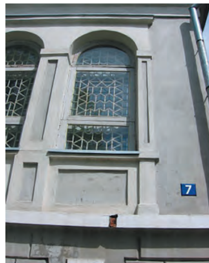
7.4. Фрагмент декоративного оздоблення головного фасаду. Фото 2007.
