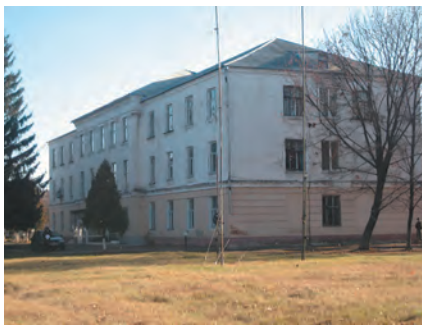
41. Вул. Харківська. Адміністративна будівля.
