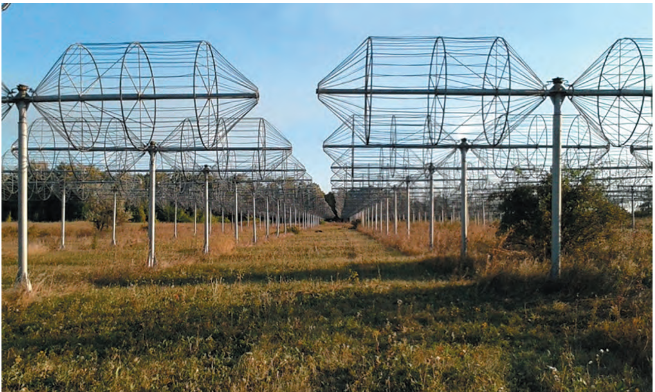
Антенни радіотелескопу УТР-2.
