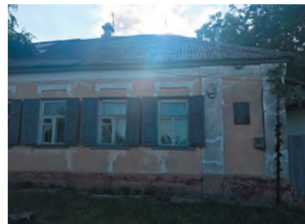
4. Вул. Литвинова, 34. Фото головного фасаду.
