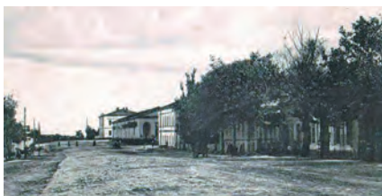
1. Фрагмент вул. Нікітінської з Будинком бригадного командира, Торговими рядами і Будинком корпусного командира кін. 19 — поч. 20 ст.
