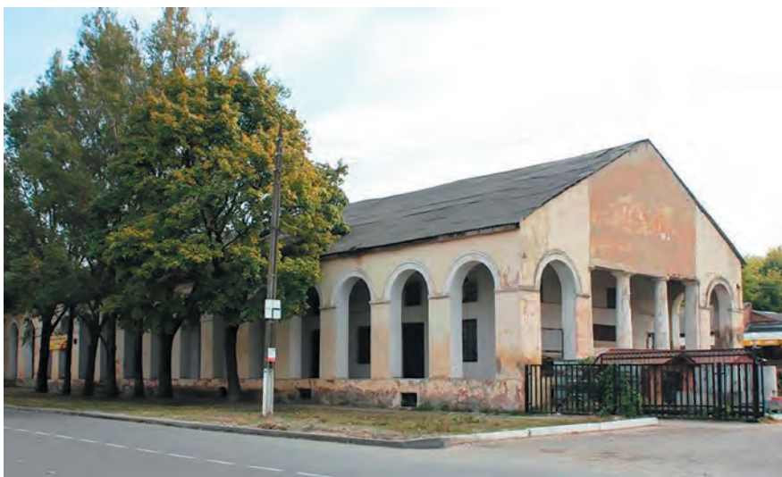
1. Загальний вигляд будівлі Торгових рядів. Фото 2017.
