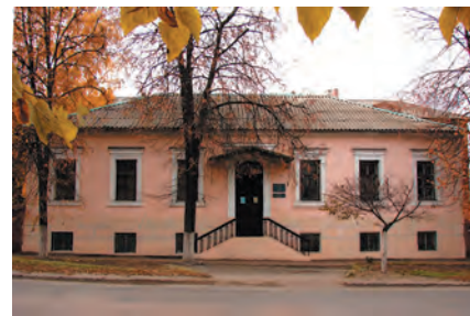
7.2. Вул. Гвардійська, 10. Загальний вигляд будинку. Фото 2007.
