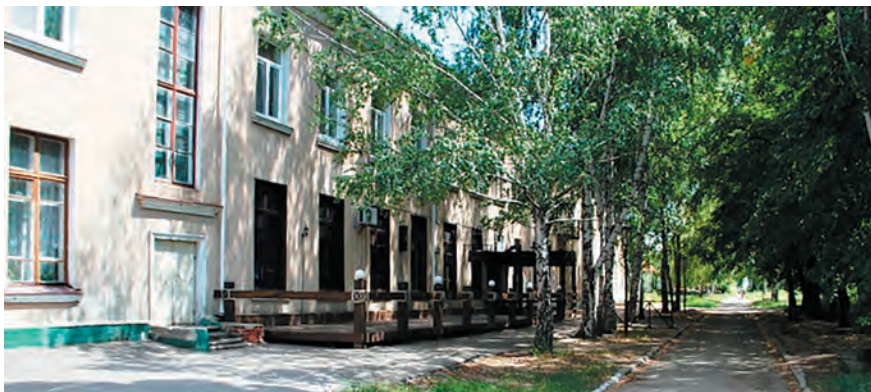
42. Фрагмент бокового фасаду. Фото 2010-х рр.
