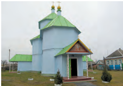
19. Вигляд з західного боку. Вхід до церкви. Фото 2009.
