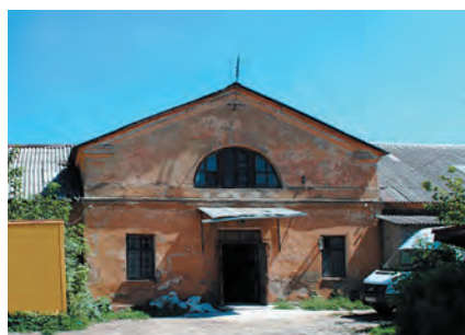
1.1. Фрагмент головного фасаду кол. службового корпусу. Фото 2016.
