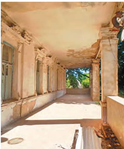
7.7. Галерея 1-го поверху. Фото 2015.
