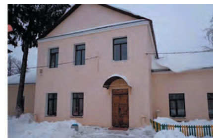
8. Фрагмент дворового фасаду. Фото 2007.
