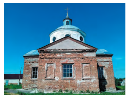
58. Східний фасад. Фото 2011.
