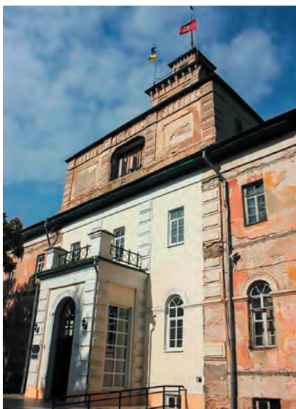
1. Фрагмент центральної частини головного фасаду будівлі Штабів військових поселень. Фото 2017.
