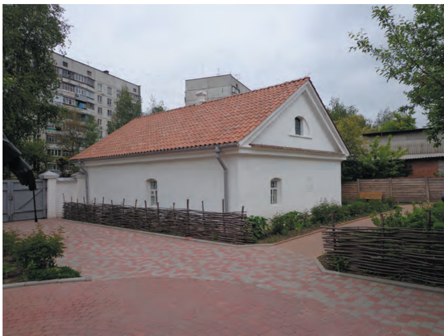
5. Західний (дворовий) фасад будинку. Фото 2016.
