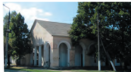
1.4. Фрагмент східного і північного фасадів. Фото 2017.
