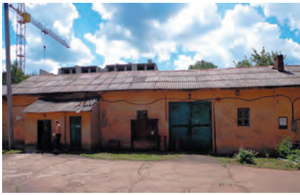
7.5. Фрагмент фасаду господарчої будівлі. Фото 2010-х рр.
