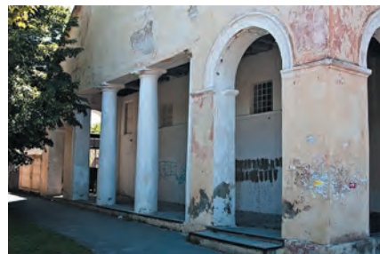
1.4. Фрагмент головного фасаду. Вхід до приміщень. Фото 2017.
