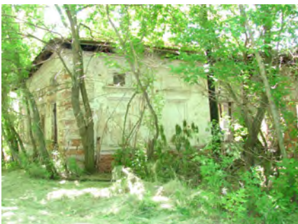
130. Фрагмент бокового фасаду. Фото 2010-х рр.
