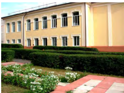
5. Загальний вигляд дворового фасаду.
