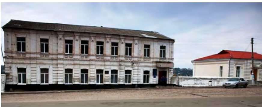
10.4. Вул. 1 Травня, 19. Головний фасад.
