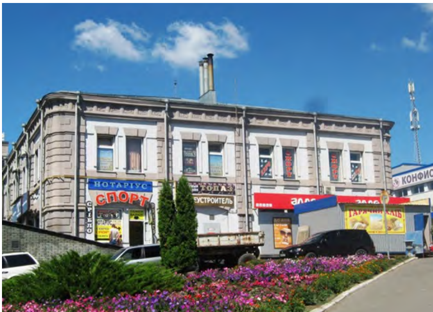
31. Пл. Центральна, 38. Загальний вигляд правобічного фасаду.
