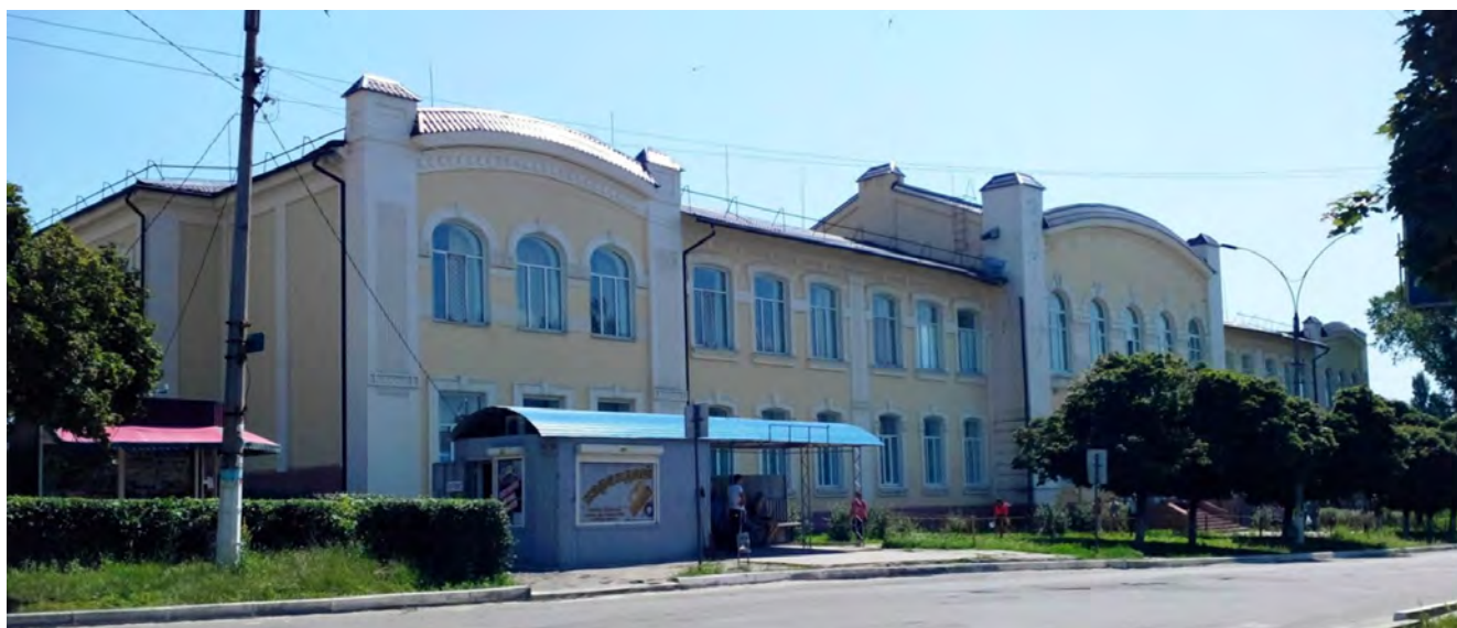
5. Вул. 1 Травня, 24. Загальний вигляд.
