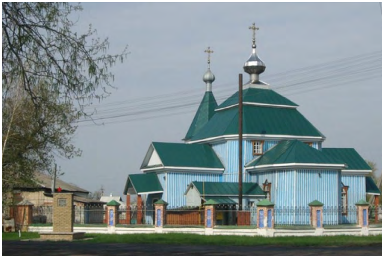
50. Вул. Бєлова, 8. Загальний вигляд.
