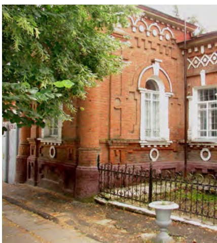
10.6. Центральний фасад. Лівобічна частина.
