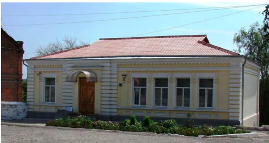
10.3. Вул. 1 Травня, 21. Загальний вигляд.
