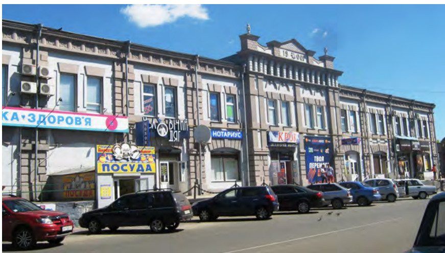
31. Пл. Центральна, 38. Торговий будинок Жестовського. Фрагмент головного фасаду.
