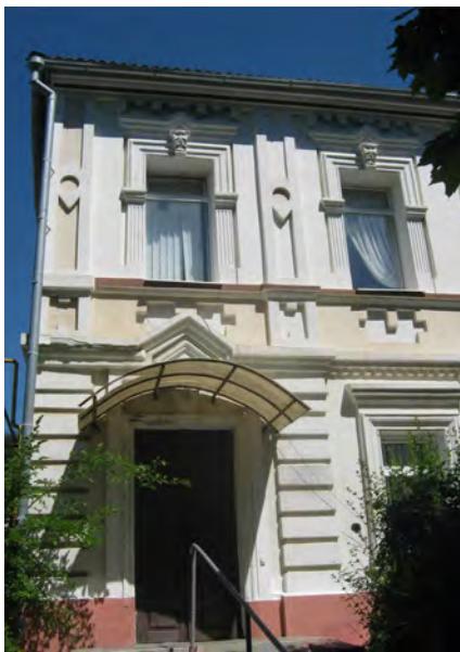
26. Фрагмент центрального фасаду. Парадний вхід.
