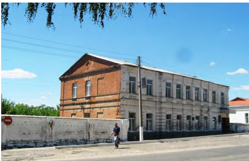
10.4. Вул. 1 Травня, 19. Загальний вигляд.
