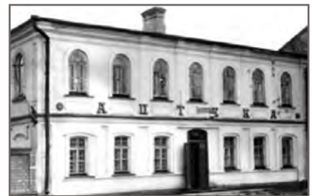
2. Просп. Конституції, 4. Будинок аптеки. Архівне фото.
