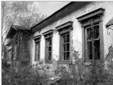
Загальний вигляд з південного боку.
