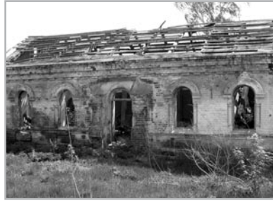
Загальний вигляд з західного боку.
