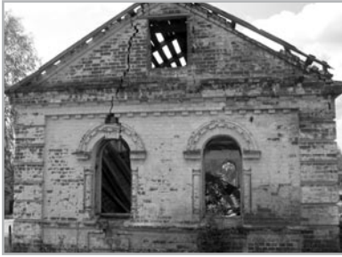
Загальний вигляд з південного боку.
