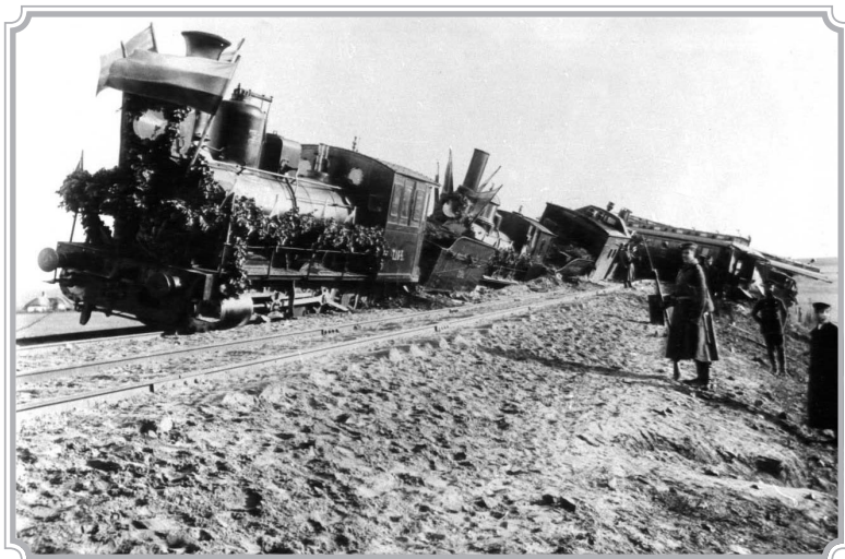
Крушение царского поезда 1 октября 1888 г. Борки. Змиевской уезд. Фото Алексея Иваницкого.
