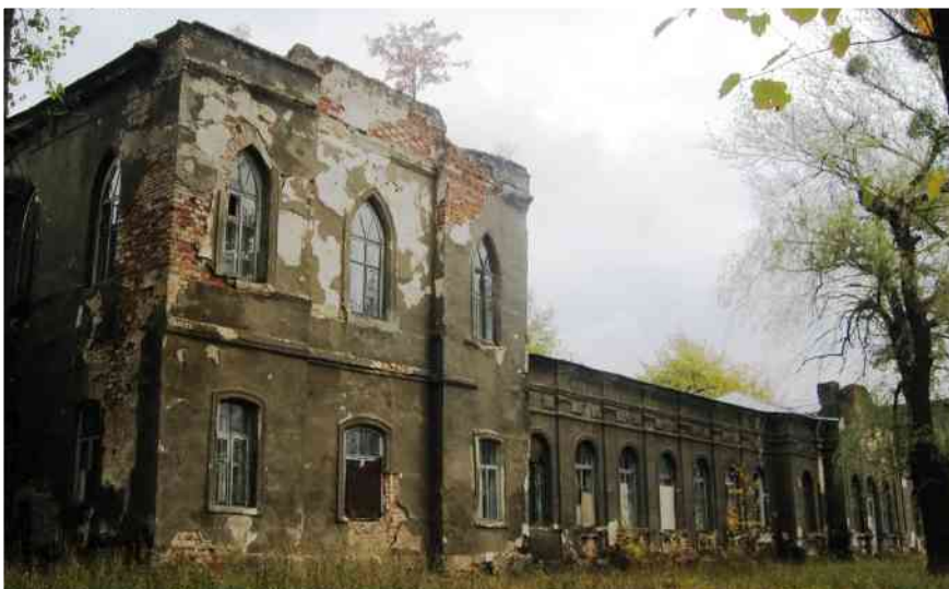
9.2. Фрагмент західного крила головного фасаду. Фото 2016.
