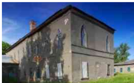
9.2. Фрагмент північного фасаду західного корпусу. Фото 2013.
