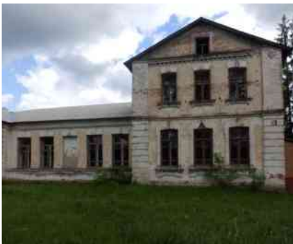
9.1. Будинок школи. Загальний вигляд. Фото 2019.
