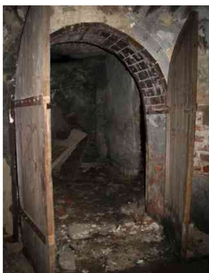
9.2. Фрагмент підвального приміщення. Фото 2016.
