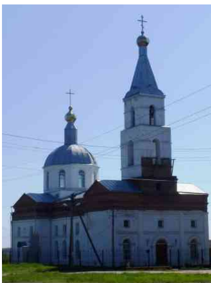
7. Вигляд із західного боку. Фото 2016.
